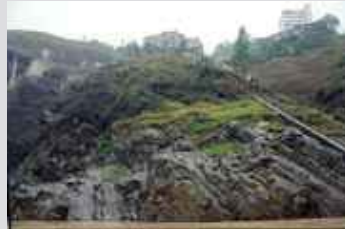
Rechts neben der Brücke entsteht auf dem Berggipfel eine neue Stadt, per Aufzug werden Lasten transportiert.
