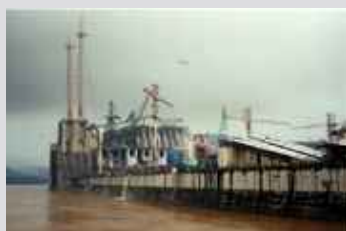
Blick auf die Baustelle des Sanxia-Staudammes vom Wasser aus
