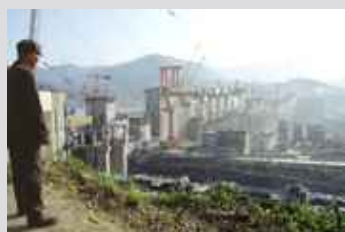
Blick vom Aussichtspunkt der Baustelle auf die Staumauer des Sanxia-Staudammes
