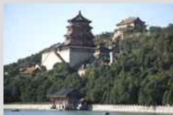
Vom Wasser aus sehen viele Bauwerke noch eindrucksvoller aus.
