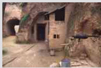
Typische Höhlenwohnungen in Lehmbauweise
